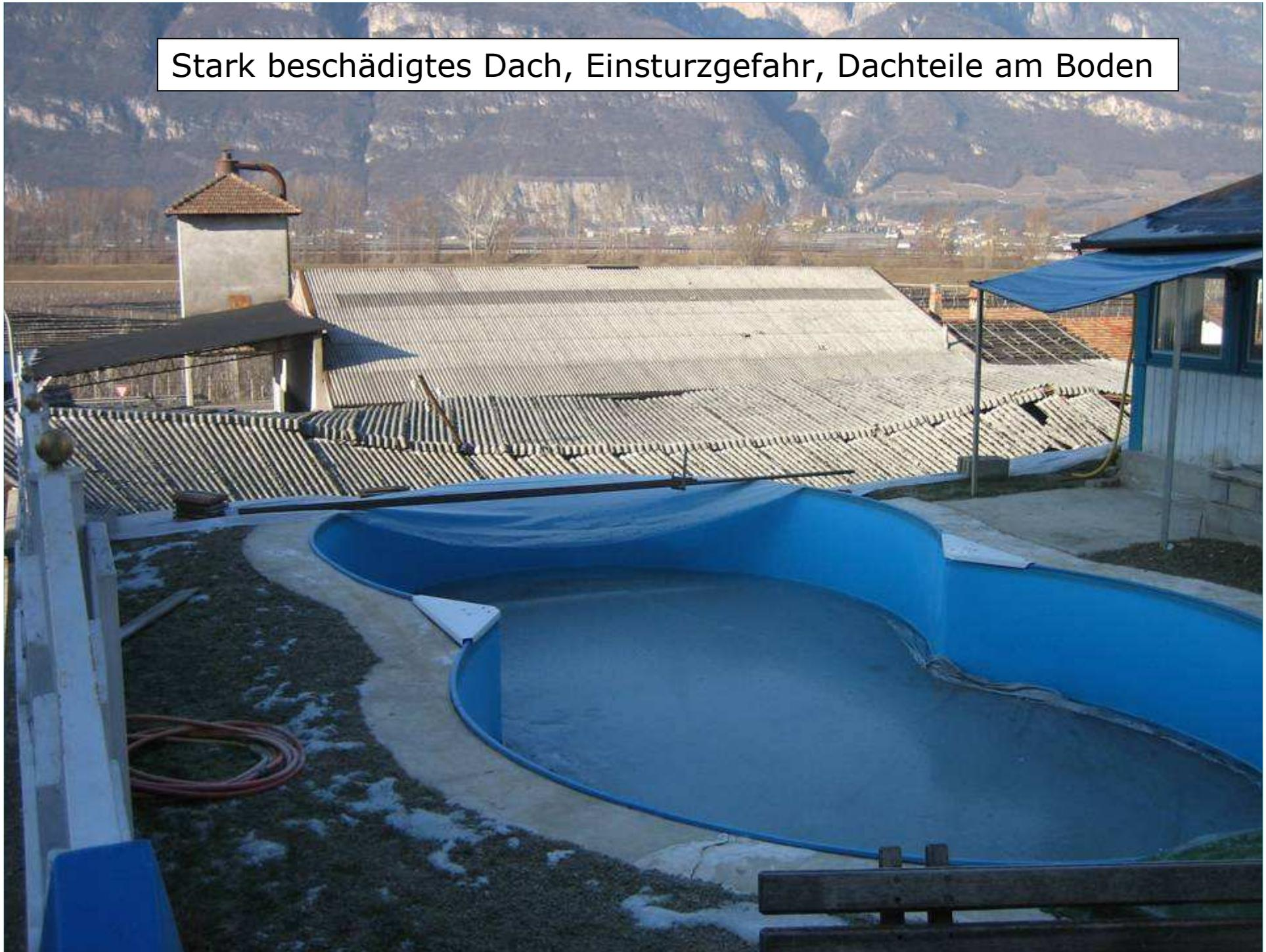
Stark beschädigtes Dach, Einsturzgefahr, Dachteile am Boden
