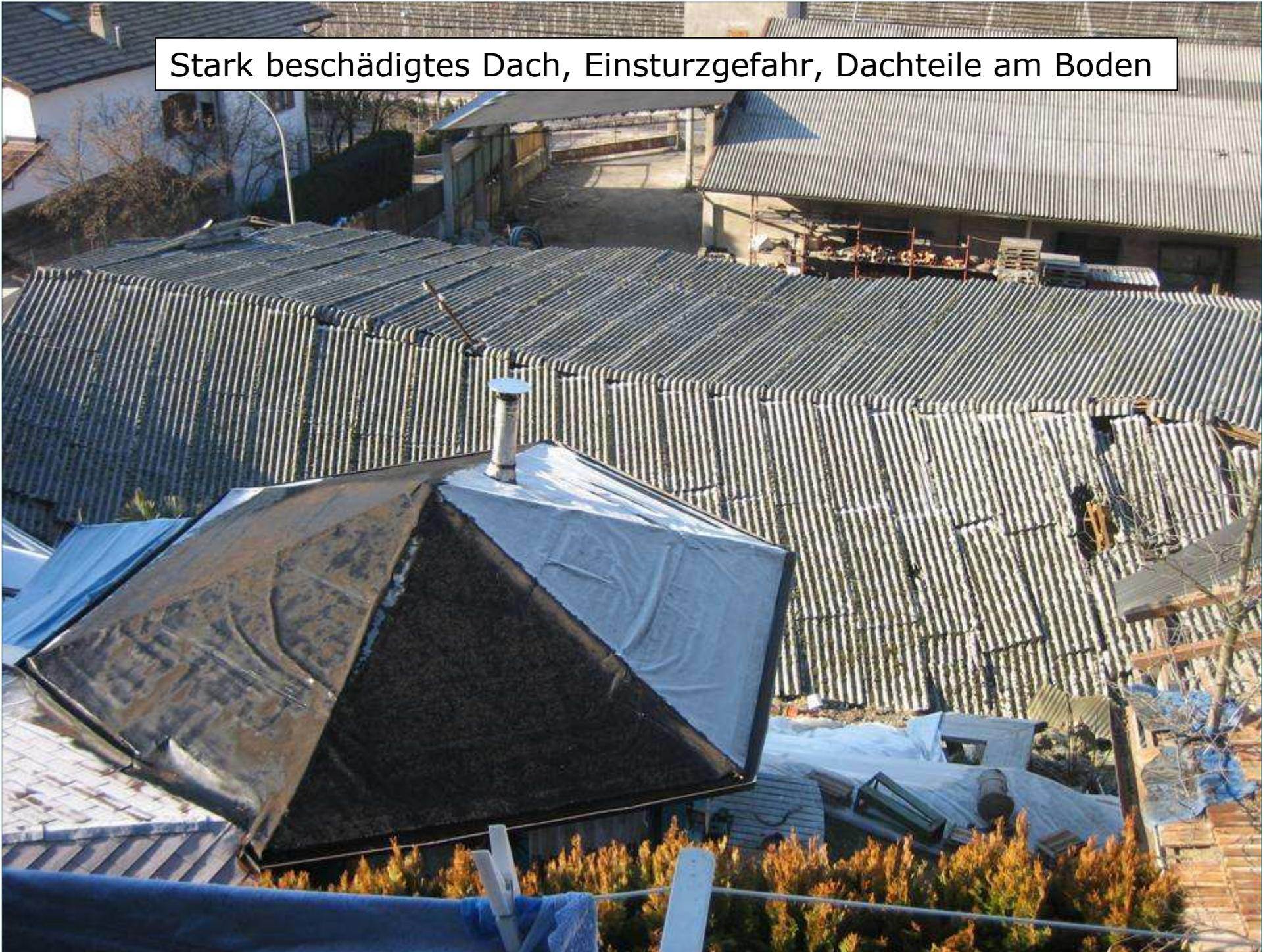
Stark beschädigtes Dach, Einsturzgefahr, Dachteile am Boden
