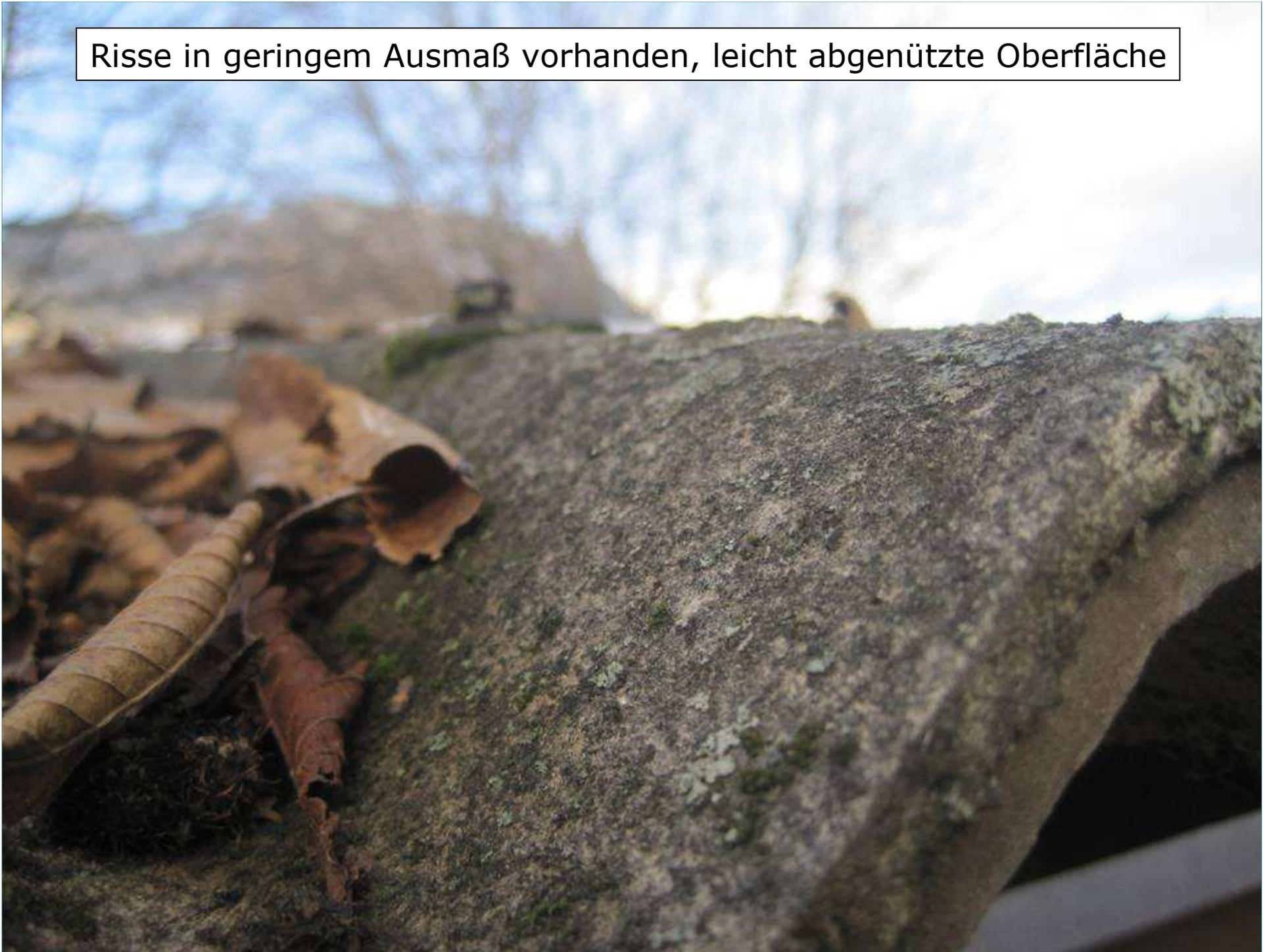
Risse in geringem Ausmaß vorhanden, leicht abgenützte Oberfläche
