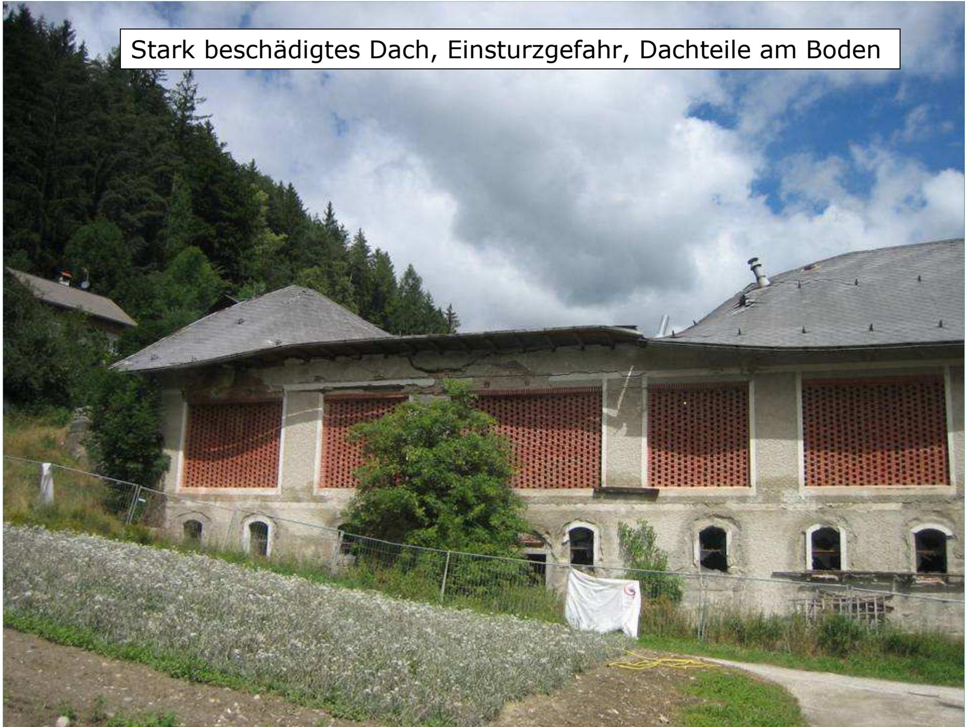
Stark beschädigtes Dach, Einsturzgefahr, Dachteile am Boden
