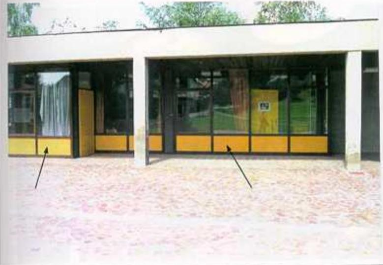
Foto 3: Volksschule, Milland: Fassadenplatten - Asbestzement
