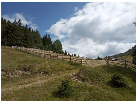
Bild 8: Beispiel eines genagelten Stangenzauns im oberen Pustertal
